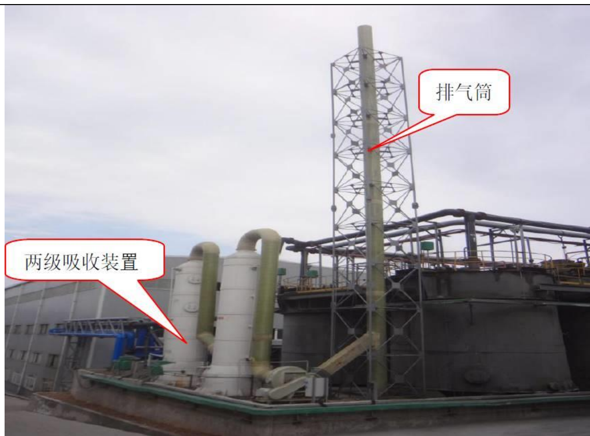
废气两级吸收装置、排气筒
