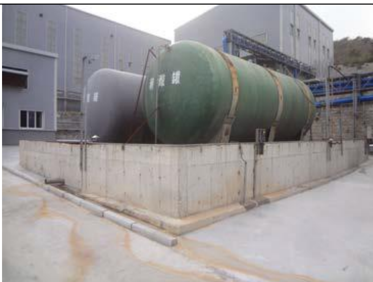
硫酸罐区围堰
