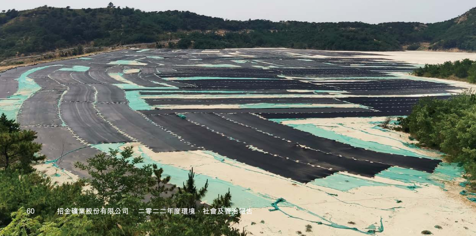
圖為尾礦庫庫區內鋪設防塵網有效降低揚塵污染
