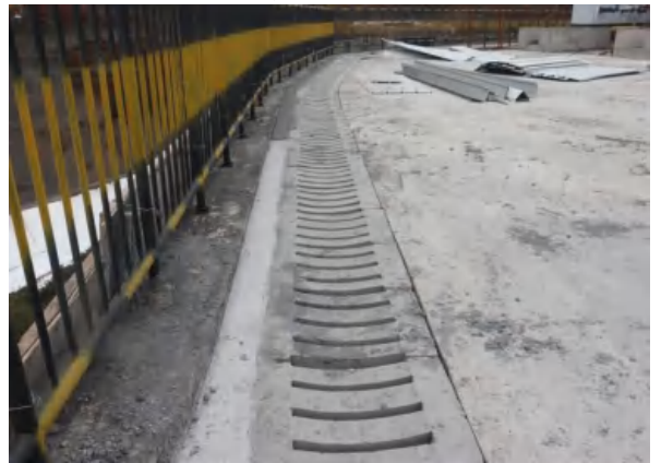
脱水车间盖板排水沟
