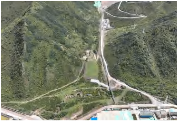
尾矿输送及回水管线
