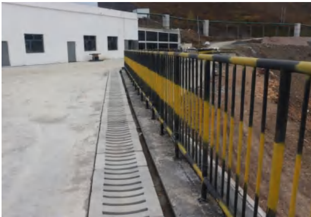
脱水车间盖板排水沟
