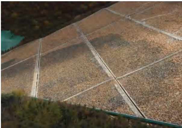
坝体干砌石护坡及排水沟
