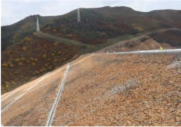
坝体干砌石护坡及排水沟
