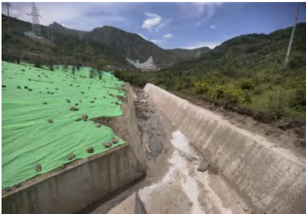
坝下尾水排水沟
