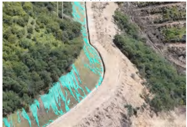
尾矿库排洪沟及上边坡喷播绿化
