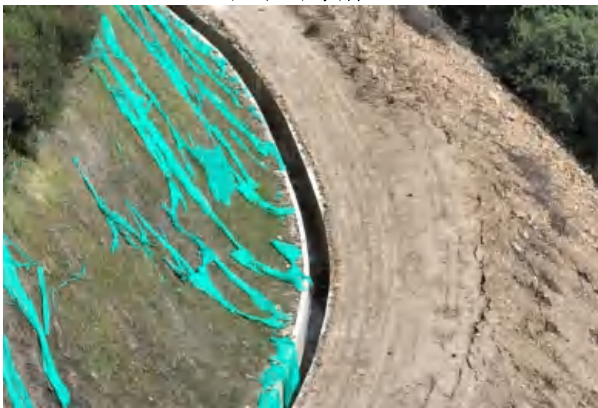
尾矿库排洪沟及上边坡喷播绿化
