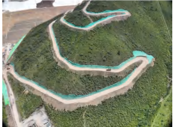
道路绿化及苫盖防护
