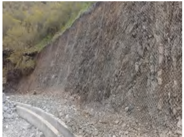
道路上边坡挂网
