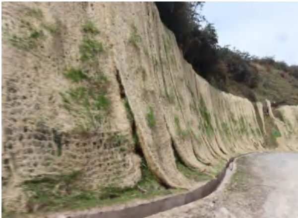
道路上边坡挂网喷播绿化
