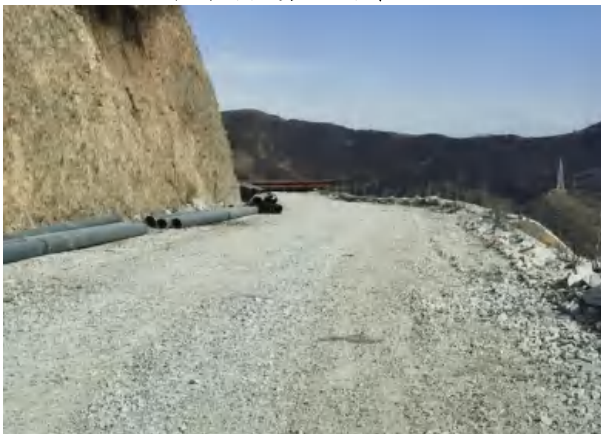
道路路面碎石压盖
