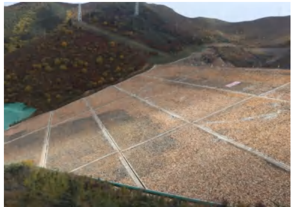
坝体干砌石护坡及排水沟
