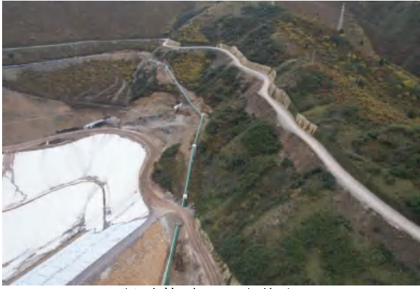
尾矿输送及回水管线
