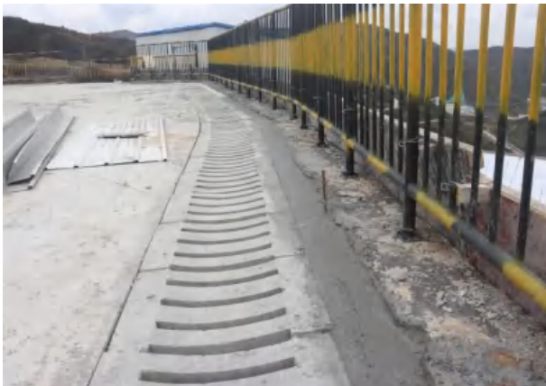
脱水车间盖板排水沟
