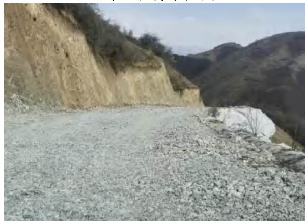
道路路面碎石压盖
