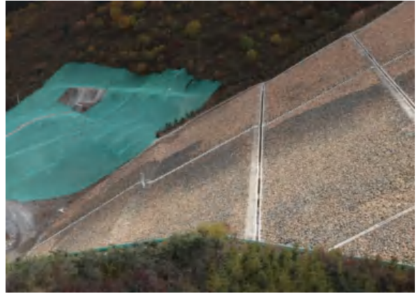
坝体干砌石护坡及排水沟
