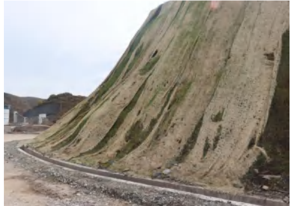
道路上边坡挂网喷播绿化
