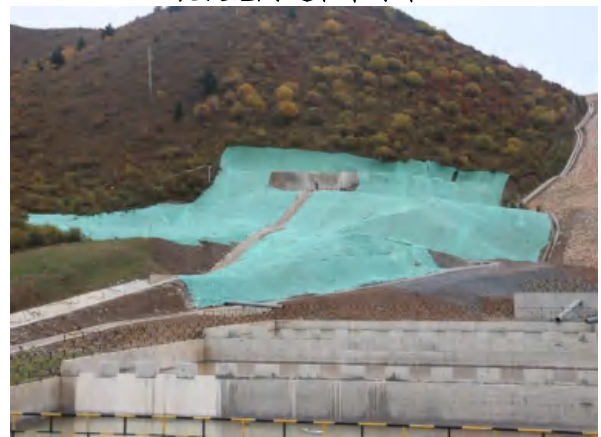
排水隧洞出口苫盖防护
