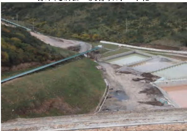
坝体外侧沉淀池、排水沟及绿化
