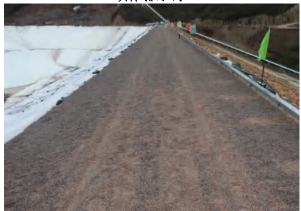
坝顶碎石压盖
