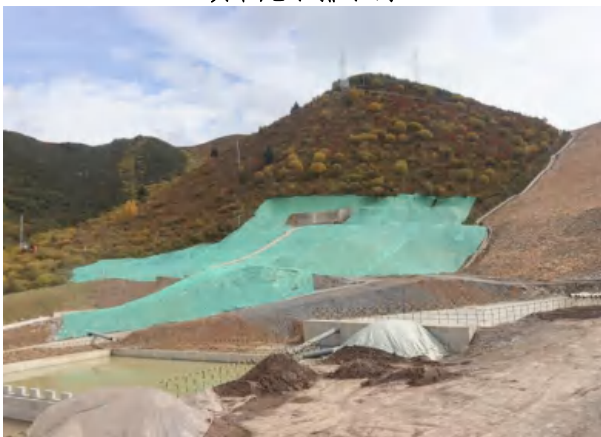
排水隧洞出口苫盖防护
