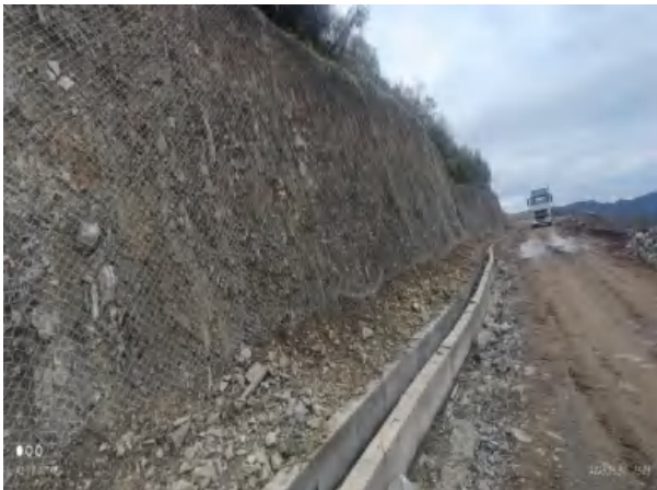
道路上边坡挂网道路上边坡挂网
