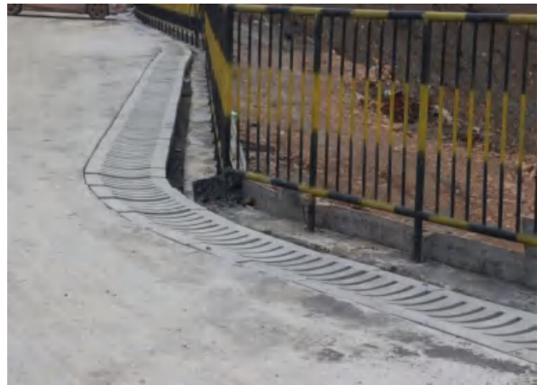
脱水车间盖板排水沟
