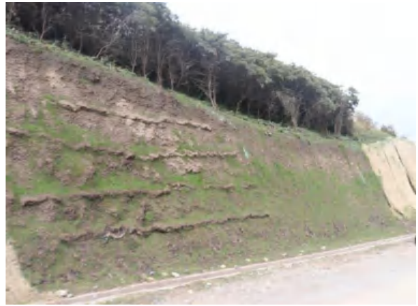
道路上边坡挂网喷播绿化
