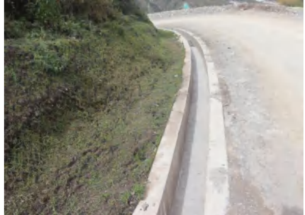
道路上边坡挂网喷播绿化及道路边沟
