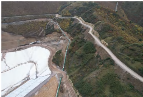
尾矿输送及回水管线
