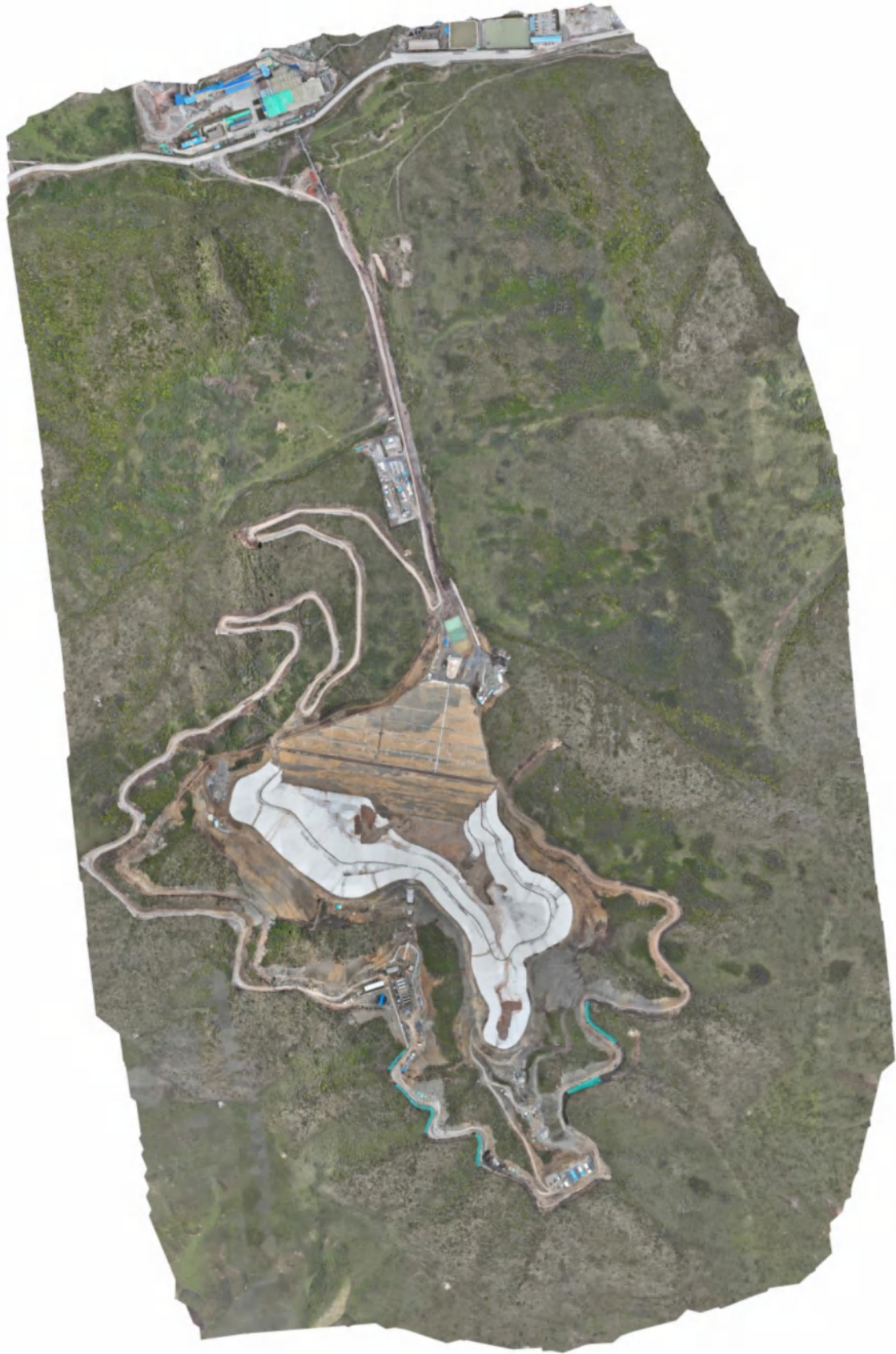
施工期影像图（无人机航拍正射影像）2023.6.1
