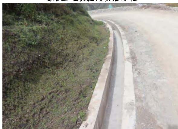
道路上边坡挂网喷播绿化及道路边沟
