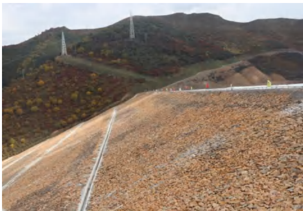
坝体干砌石护坡及排水沟
