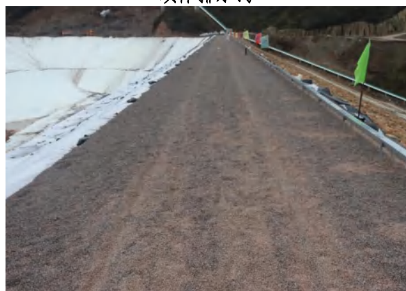
坝顶碎石压盖
