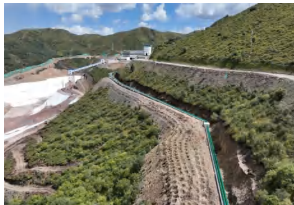
尾矿输送及回水管线
