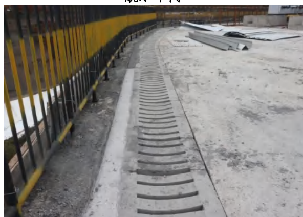
脱水车间盖板排水沟
