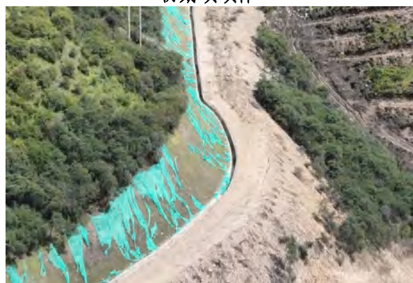
尾矿库排洪沟及上边坡喷播绿化
