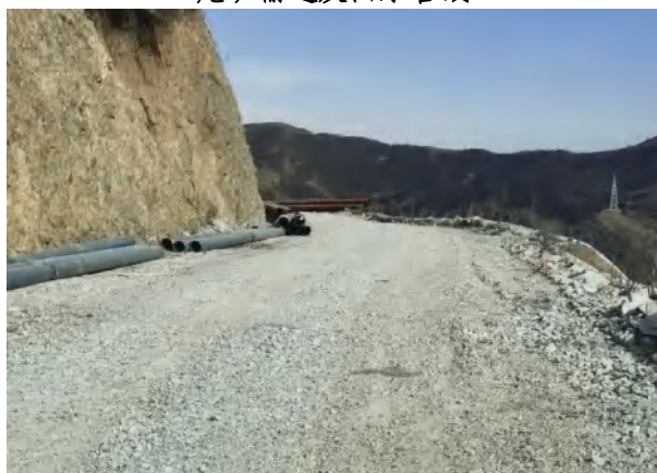
道路路面碎石压盖
