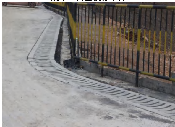
脱水车间盖板排水沟
