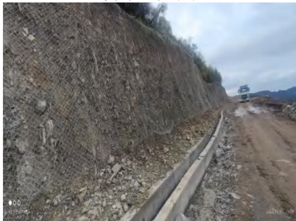
道路上边坡挂网道路上边坡挂网
