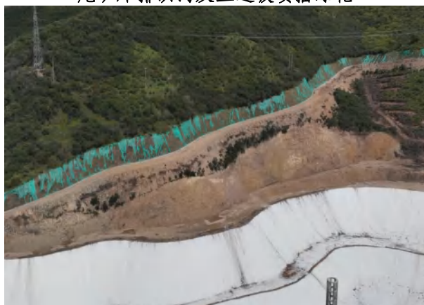
尾矿库排洪沟上边坡喷播绿化
