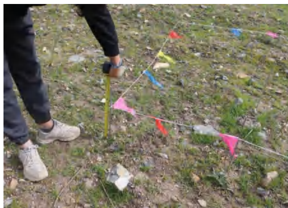
图 1.12 施工生产生活区 12#监测点 (恢复期)
