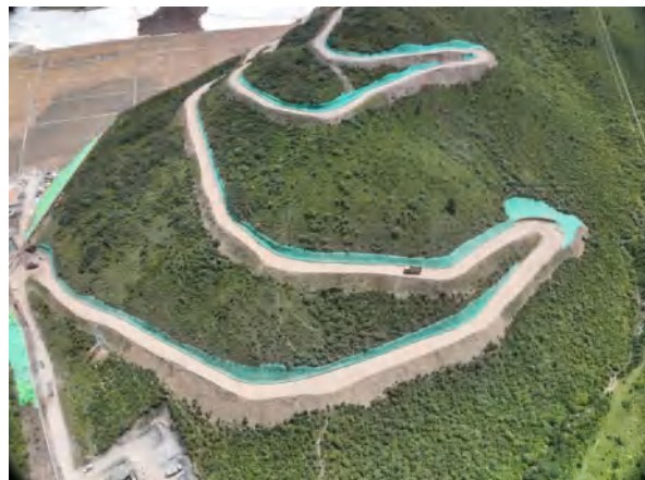
道路绿化及苫盖防护
