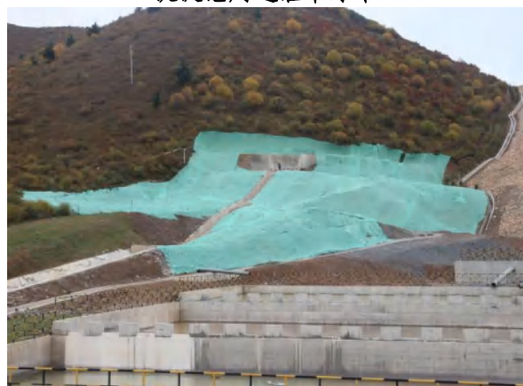
排水隧洞出口苫盖防护
