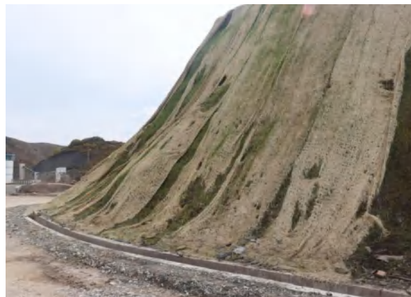
道路上边坡挂网喷播绿化
