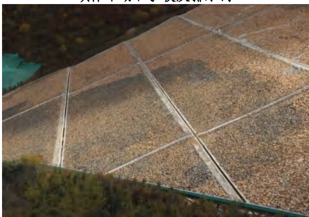
坝体干砌石护坡及排水沟
