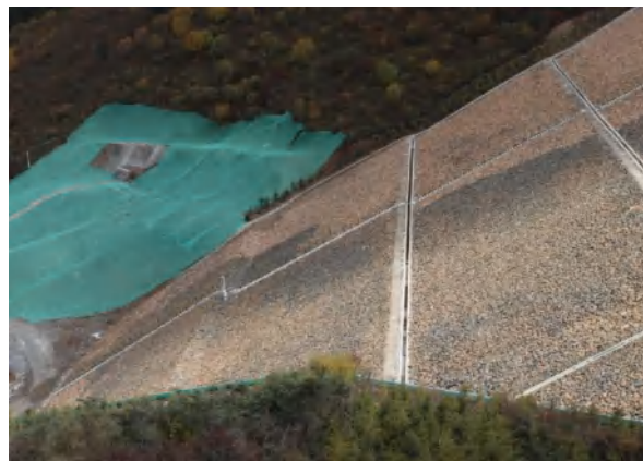
坝体干砌石护坡及排水沟
