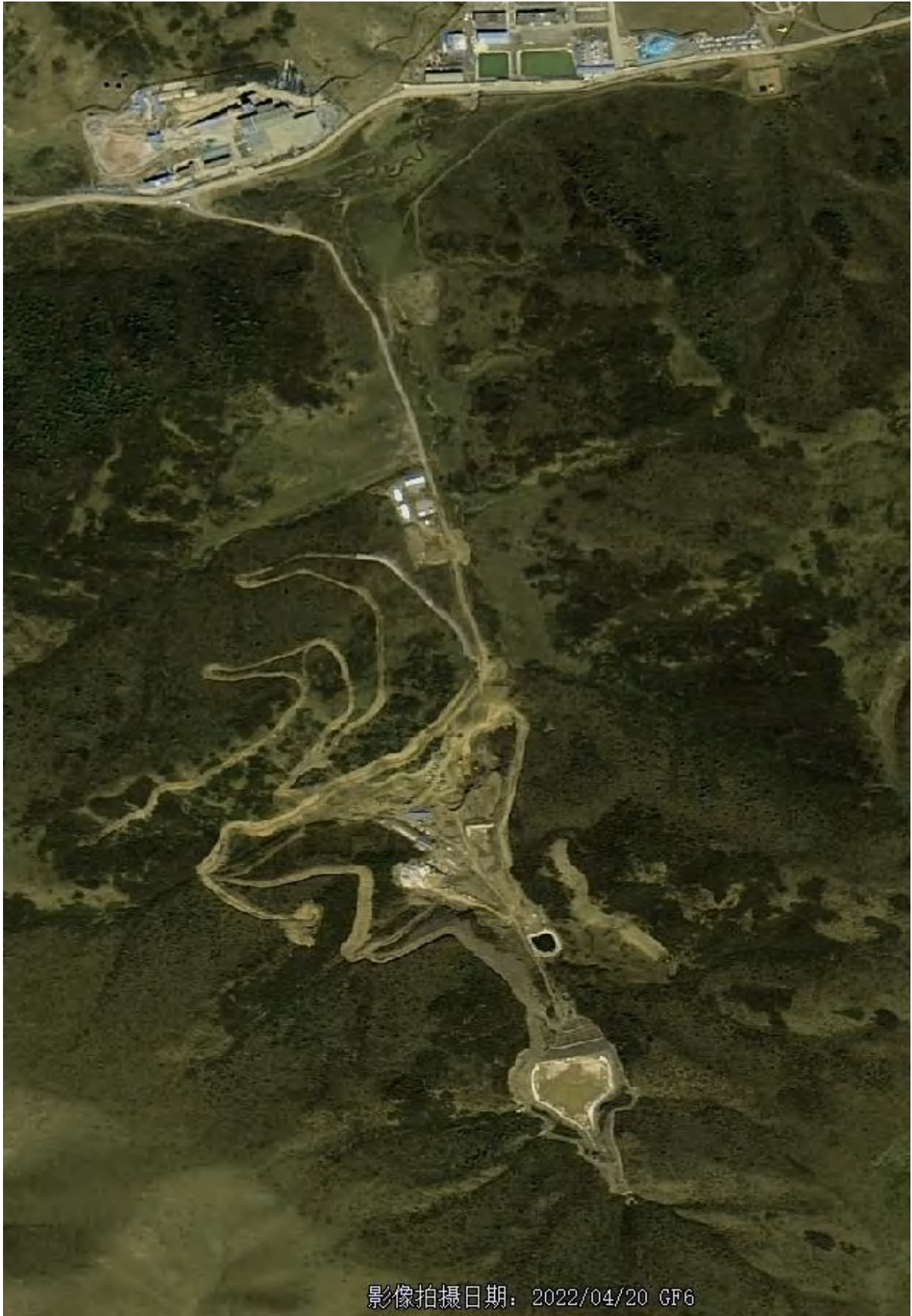
施工期影像图 2022.4.20
