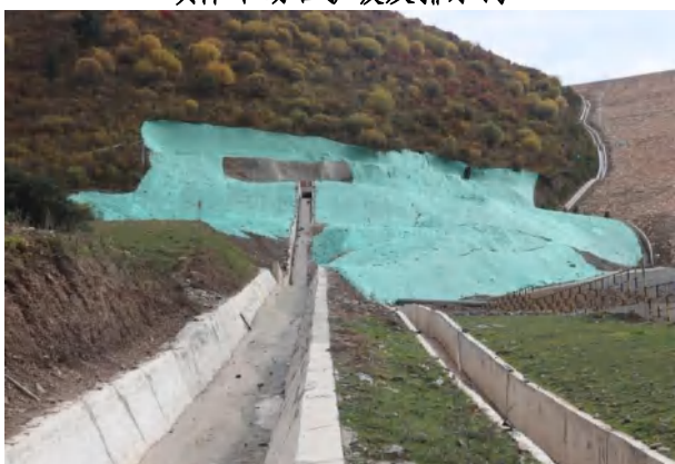
排水隧洞出口及排洪沟、绿化
