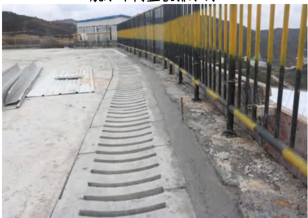
脱水车间盖板排水沟
