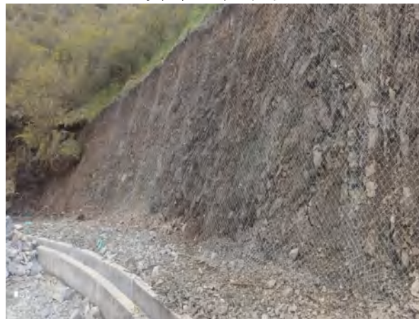
道路上边坡挂网
