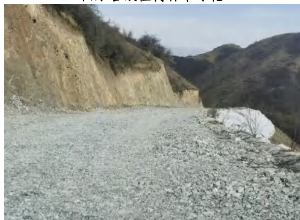
道路路面碎石压盖
