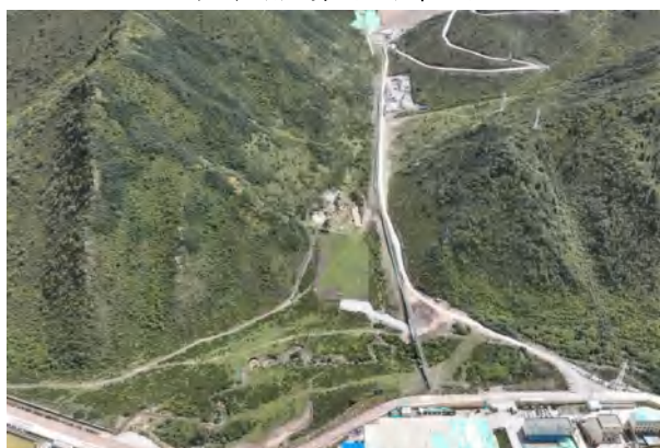
尾矿输送及回水管线
