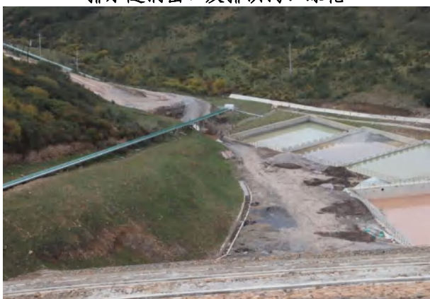
坝体外侧沉淀池、排水沟及绿化
