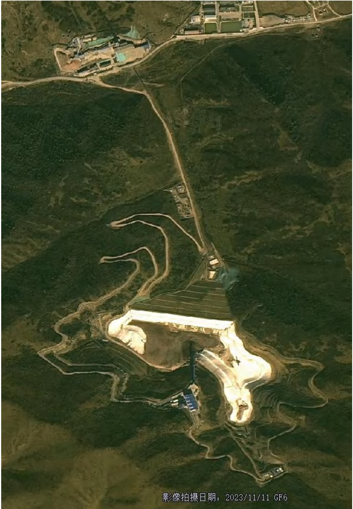
施工后影像图 2023.11.11
