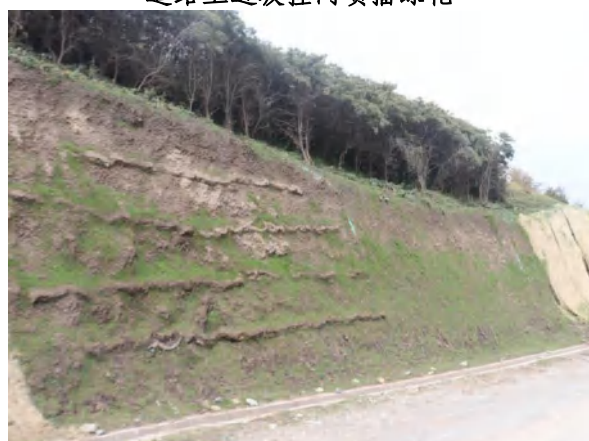
道路上边坡挂网喷播绿化
