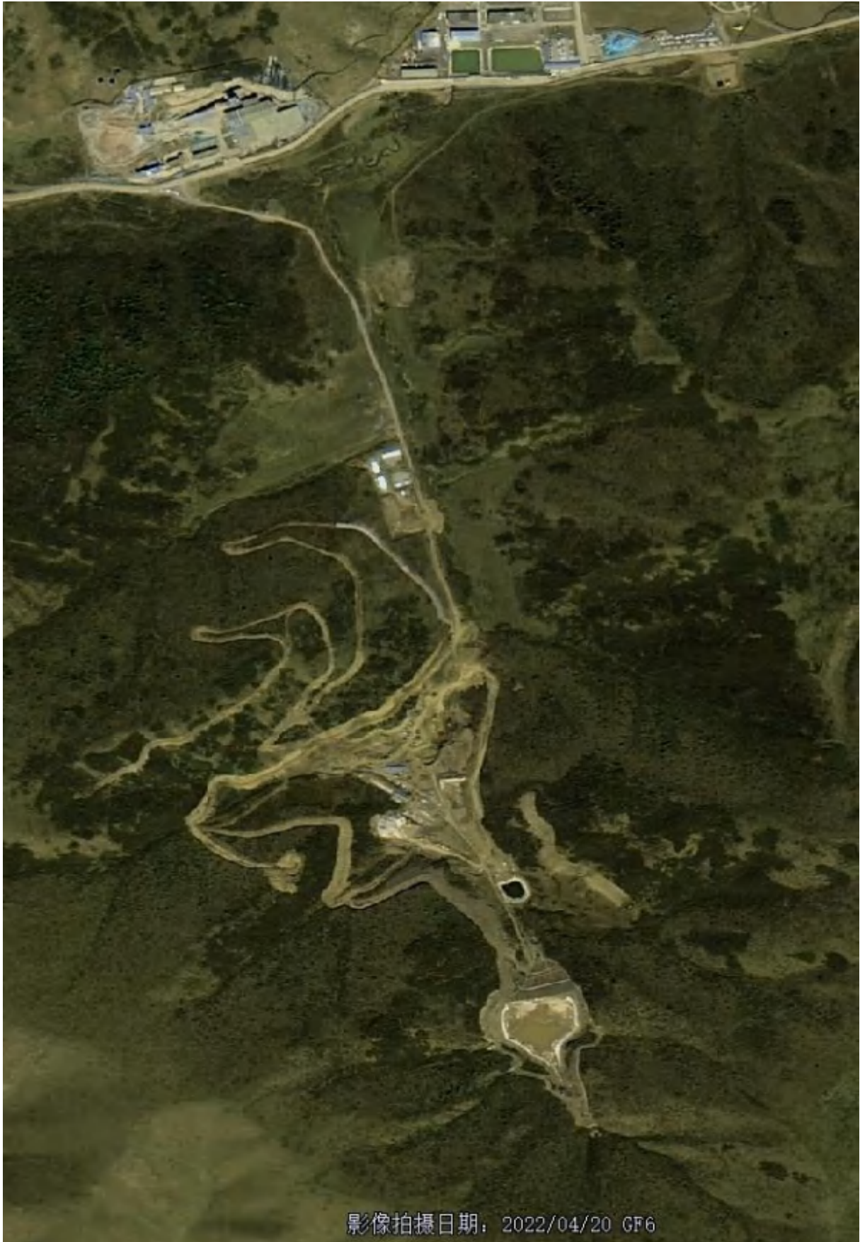
施工期影像图 2022.4.20
