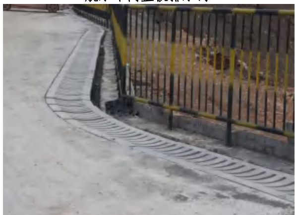
脱水车间盖板排水沟
