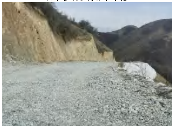
道路路面碎石压盖
