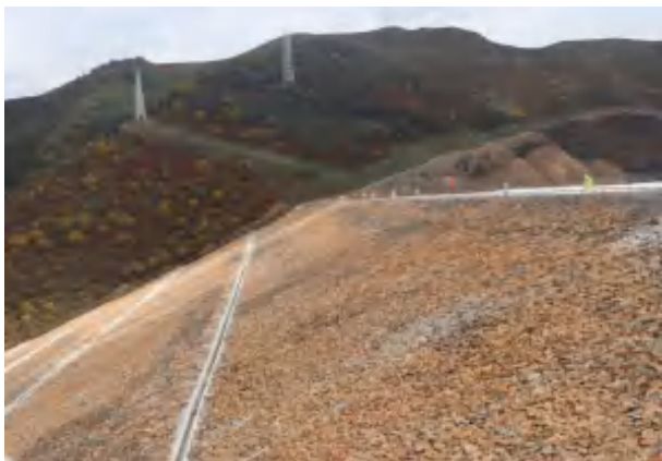
坝体干砌石护坡及排水沟
