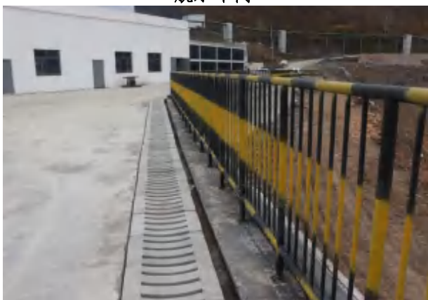
脱水车间盖板排水沟
