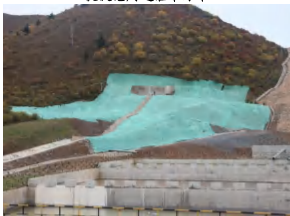
排水隧洞出口苫盖防护
