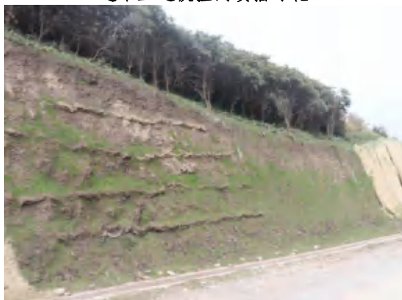
道路上边坡挂网喷播绿化
