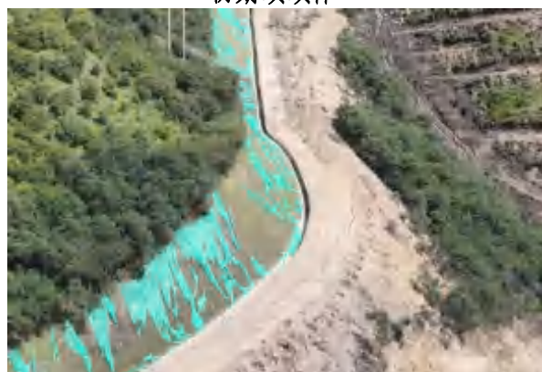
尾矿库排洪沟及上边坡喷播绿化
