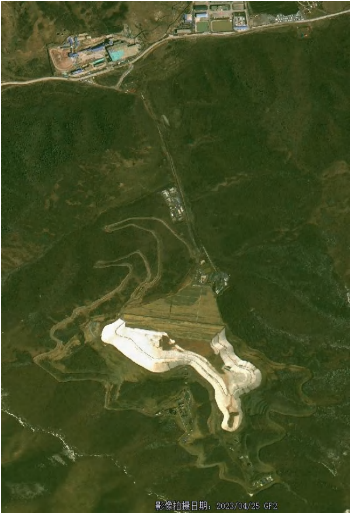
施工期影像图 2023.4.25
