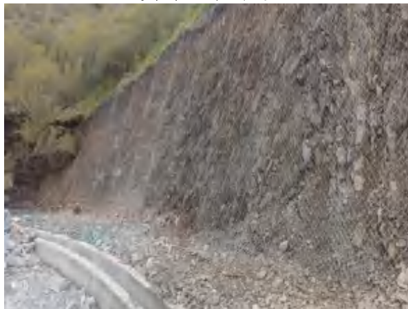
道路上边坡挂网
