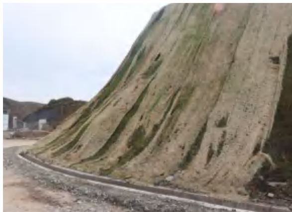
道路上边坡挂网喷播绿化
