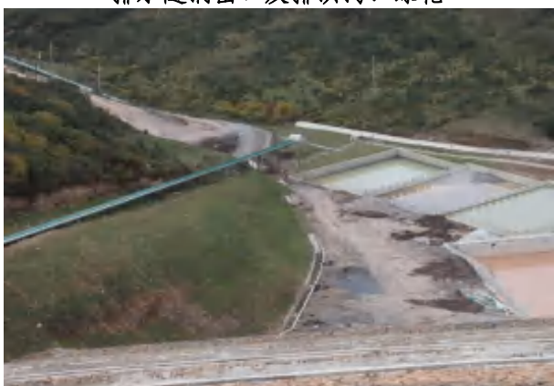
坝体外侧沉淀池、排水沟及绿化
