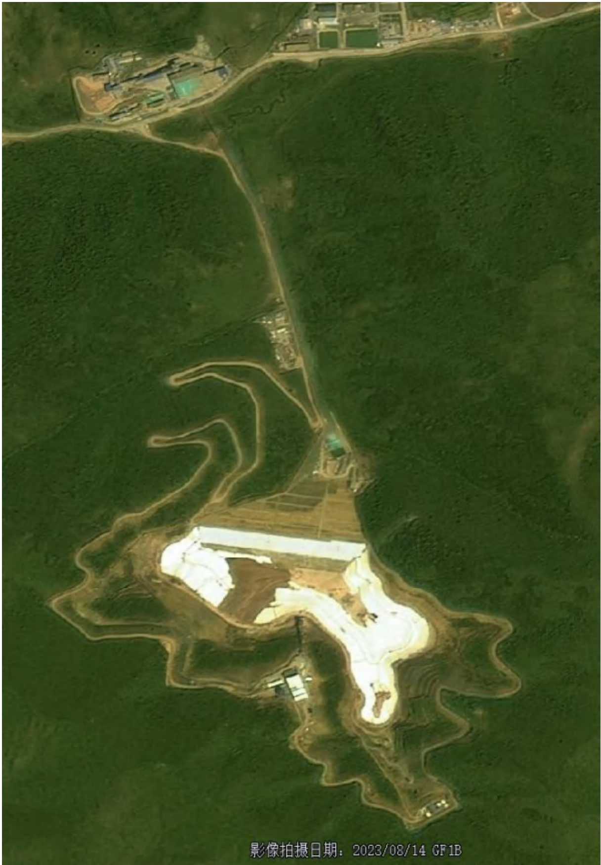
施工期影像图 2023.8.14
