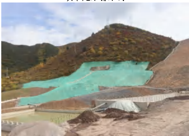
排水隧洞出口苫盖防护
