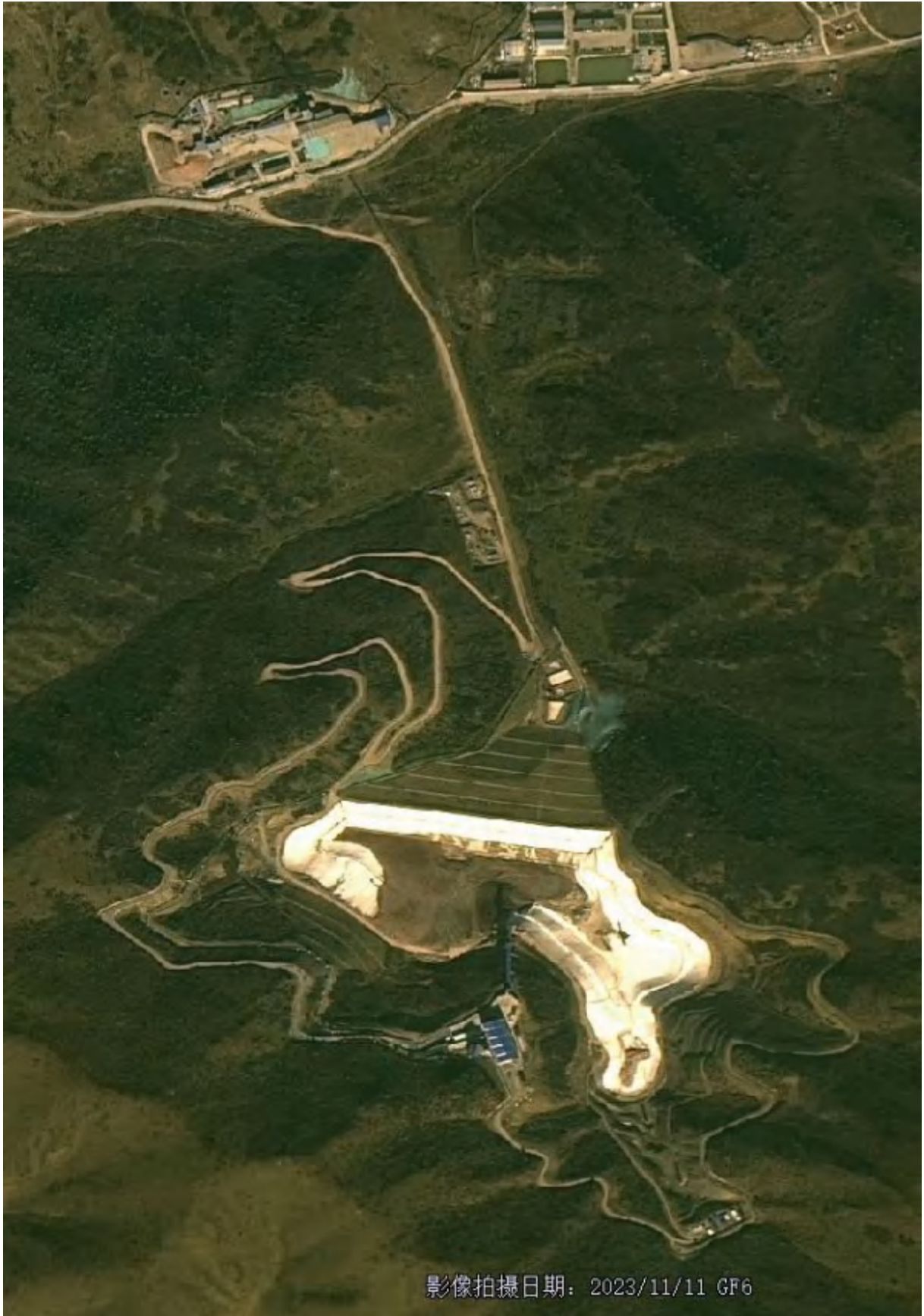
施工后影像图 2023.11.11
