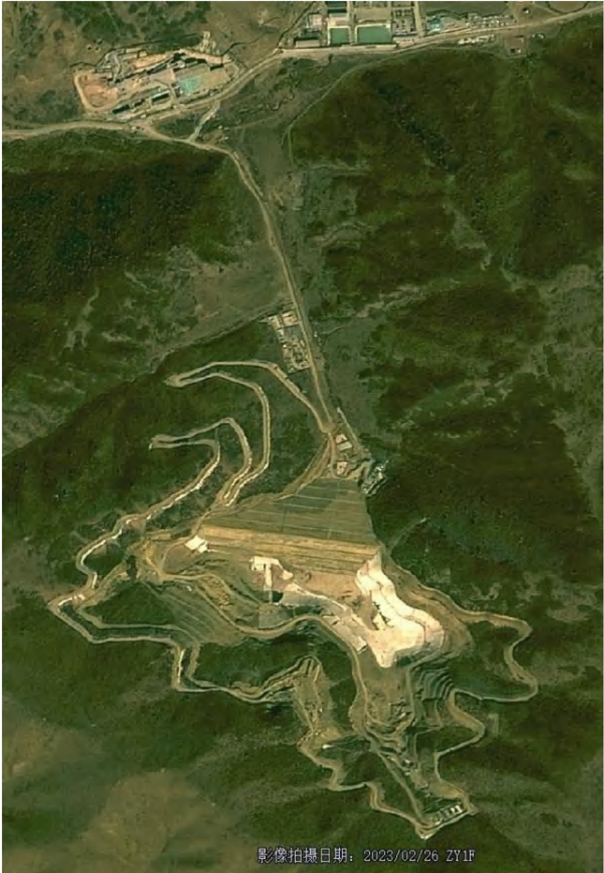
施工期影像图 2023.2.26
