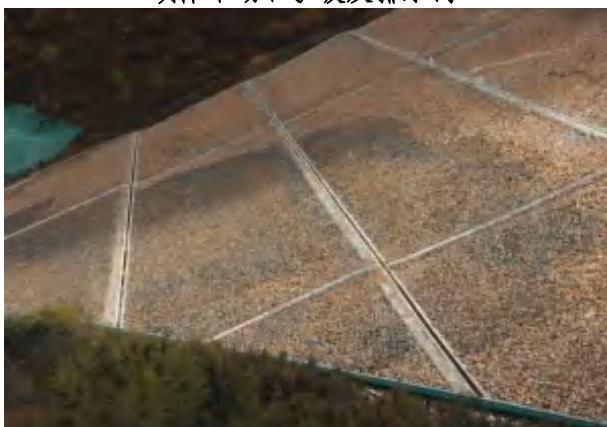
坝体干砌石护坡及排水沟
