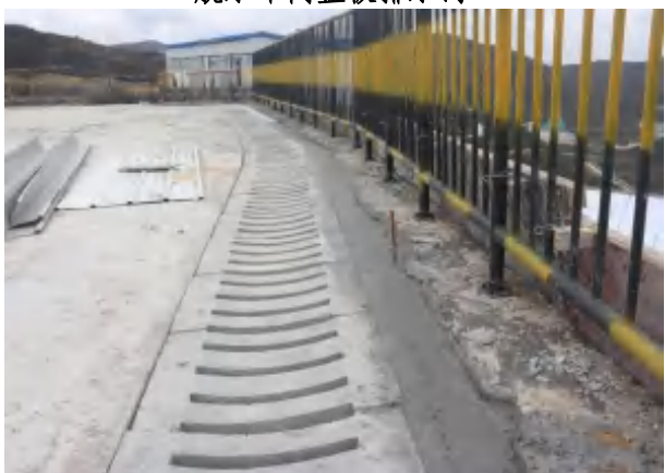
脱水车间盖板排水沟
