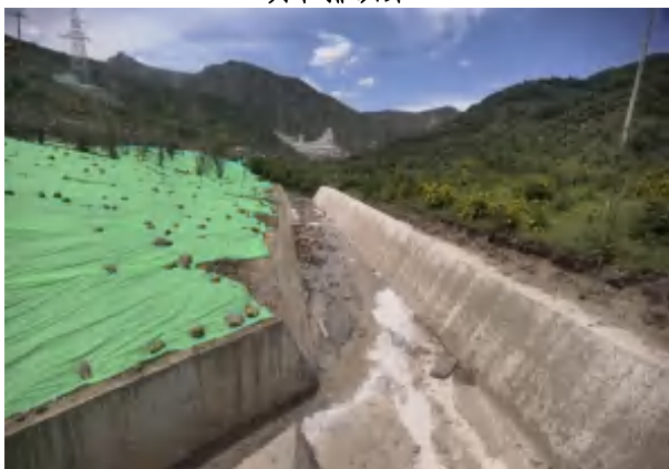
坝下尾水排水沟
