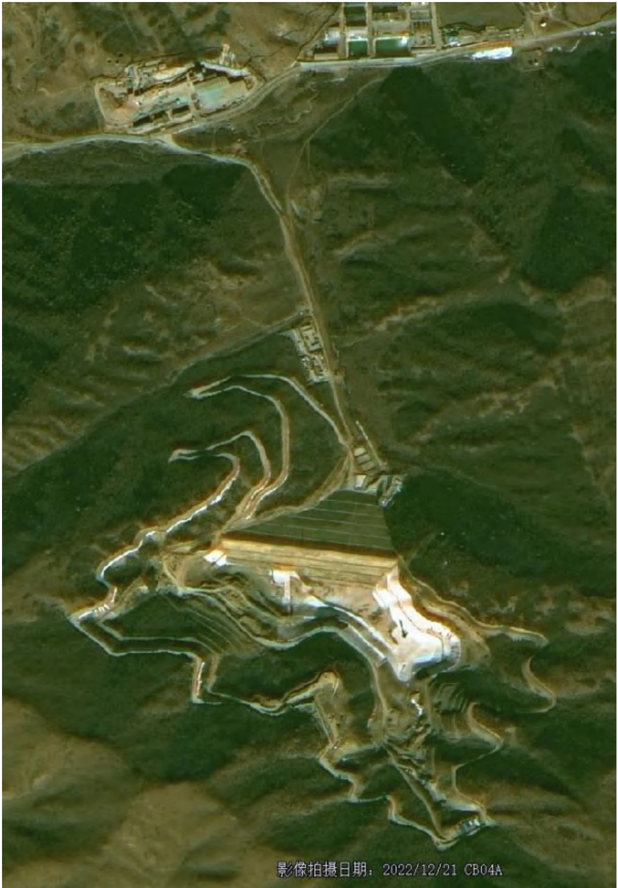
施工期影像图 2022.12.21
