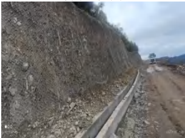
道路上边坡挂网道路上边坡挂网
