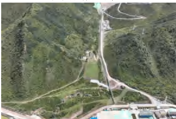
尾矿输送及回水管线
