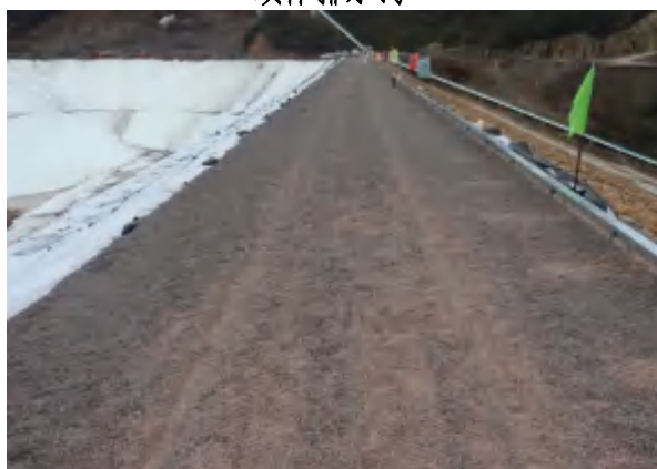
坝顶碎石压盖
