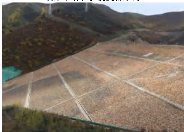
坝体干砌石护坡及排水沟
