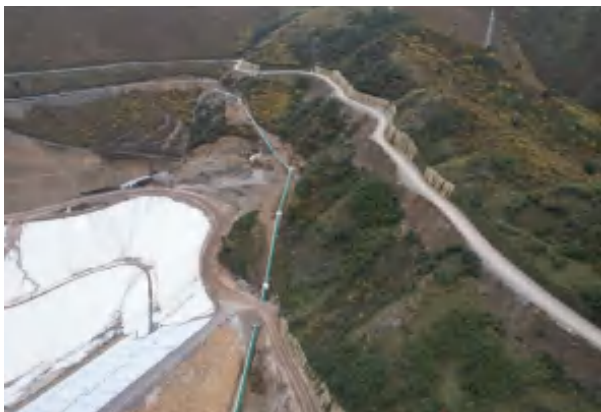
尾矿输送及回水管线
