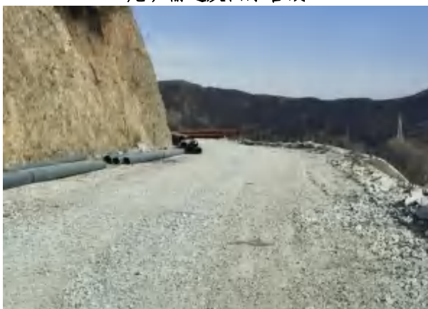
道路路面碎石压盖
