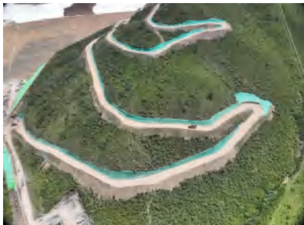
道路绿化及苫盖防护
