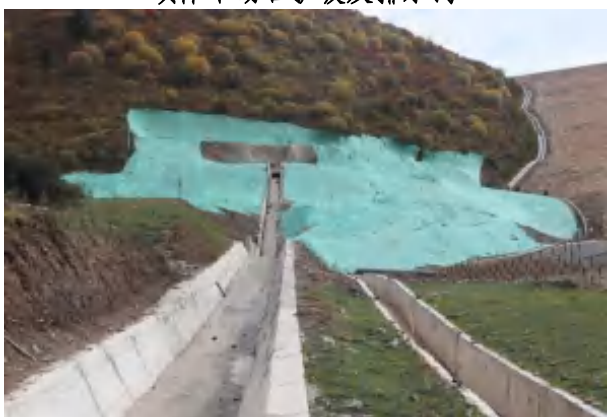
排水隧洞出口及排洪沟、绿化
