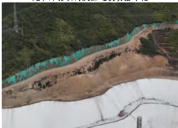
尾矿库排洪沟上边坡喷播绿化
