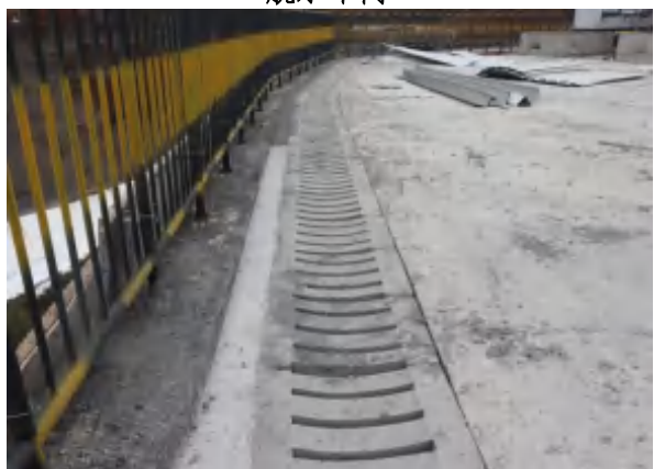
脱水车间盖板排水沟
