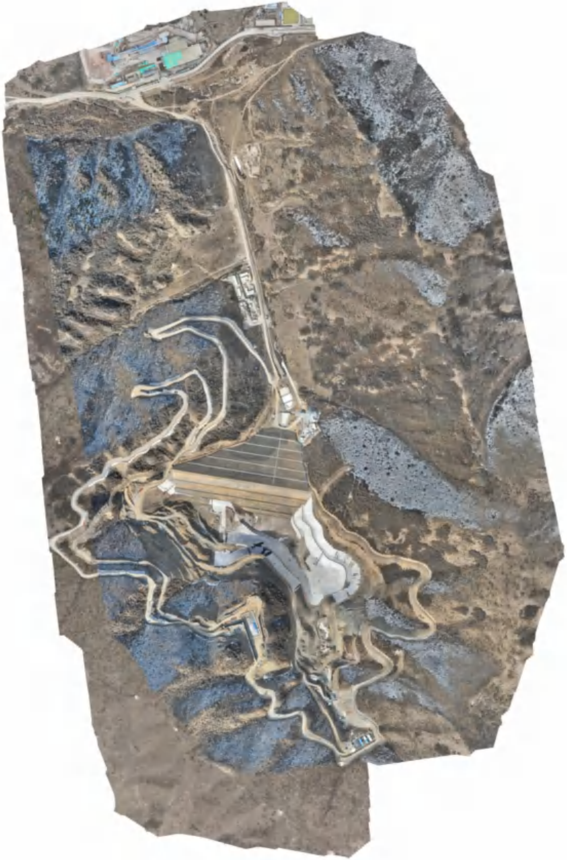
施工期影像图（无人机航拍正射影像）2023.1.16
