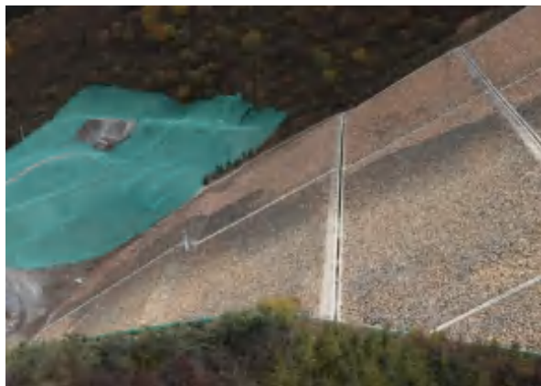
坝体干砌石护坡及排水沟
