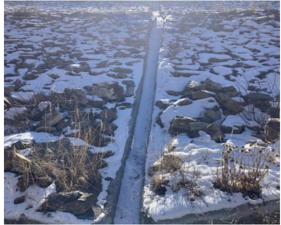
尾矿库坝体坡面急流槽
