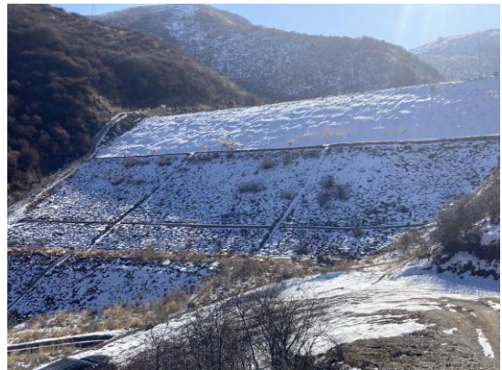
尾矿库坝体坡面急流槽
