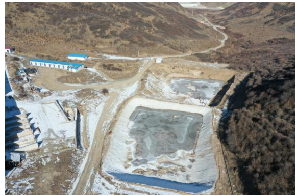
蓄水池、事故池
