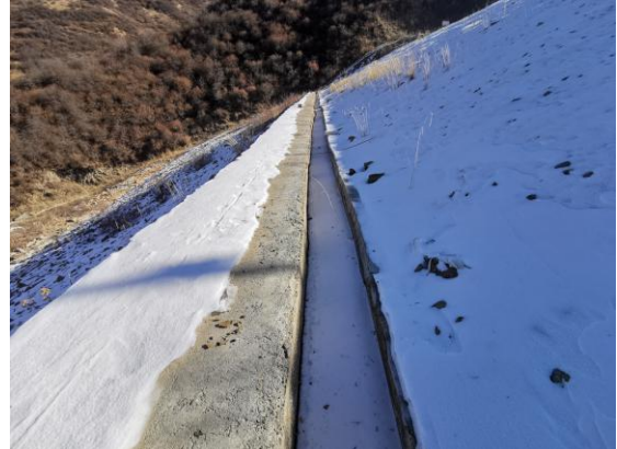
库区坝体边坡马道排水沟
