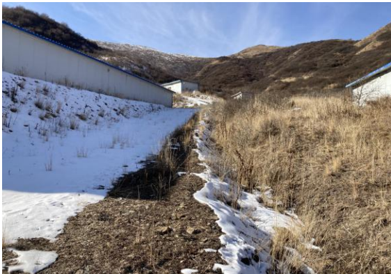
办公生活区临时排水沟
