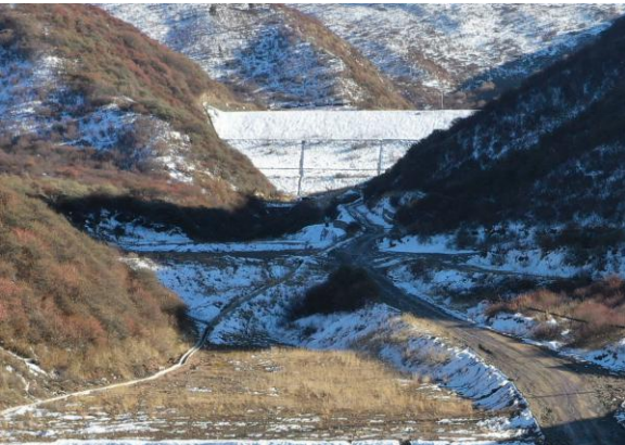
尾矿库植被恢复
