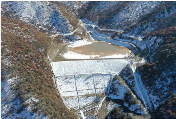
尾矿库库区及截水沟
