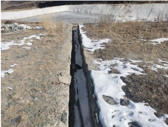
尾矿库下游排水沟
