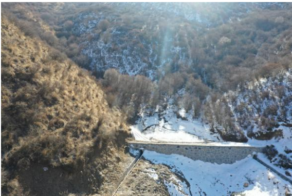
尾矿库库区上游防洪坝
