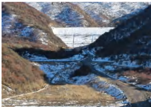
尾矿库植被恢复
