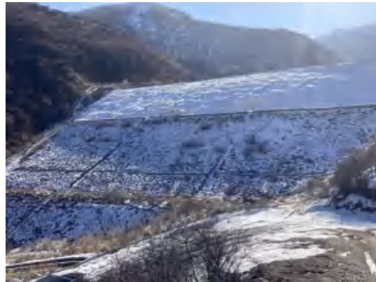
尾矿库坝体坡面急流槽
