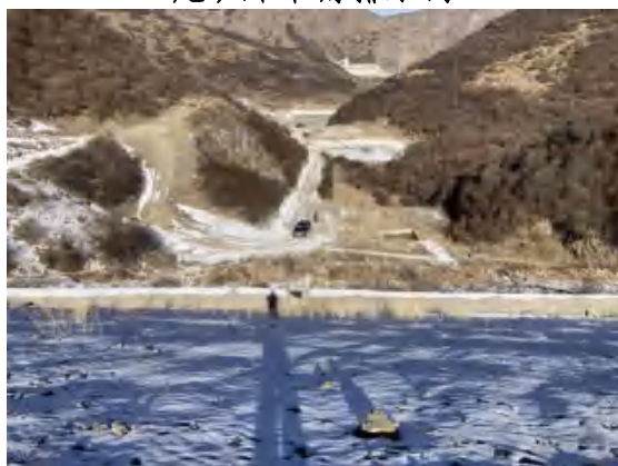
尾矿库植被恢复
