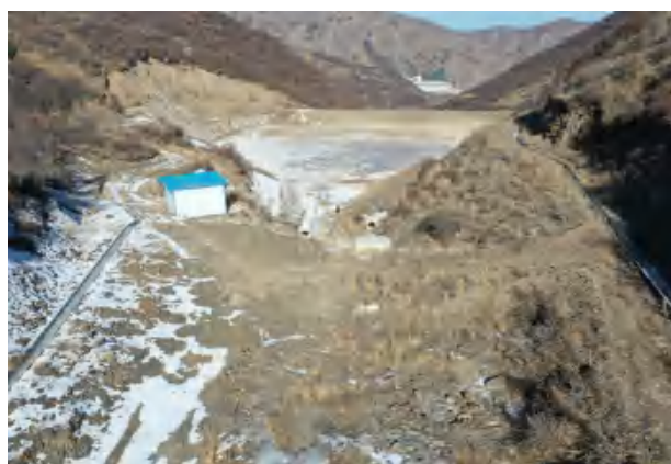
尾矿库坝体坡面急流槽
