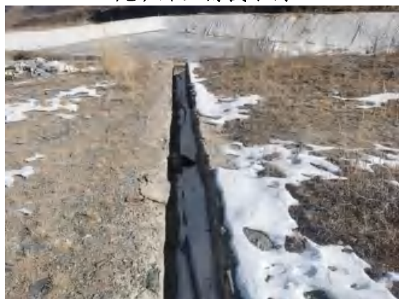
尾矿库下游排水沟
