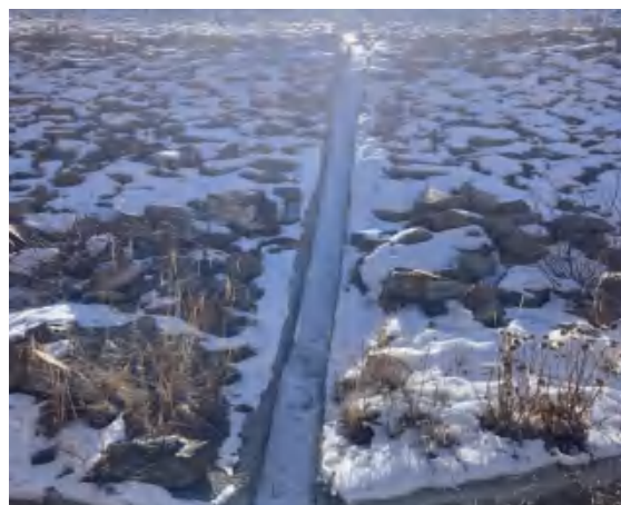
尾矿库坝体坡面急流槽
