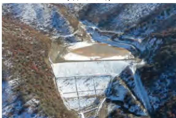
尾矿库库区及截水沟
