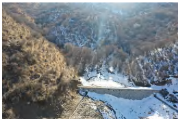
尾矿库库区上游防洪坝
