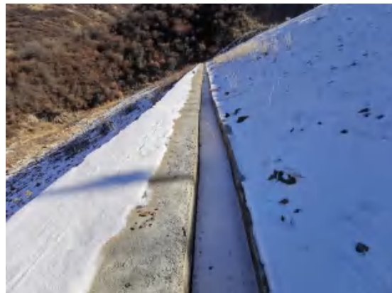
库区坝体边坡马道排水沟
