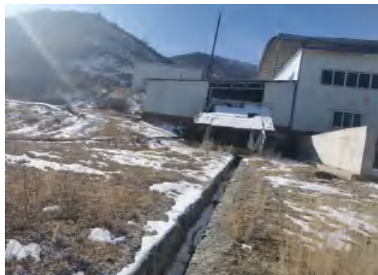
工业场地排水沟
