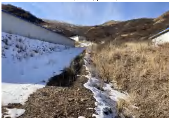
办公生活区临时排水沟
