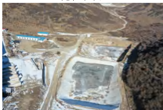
蓄水池、事故池
